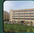
廣西賓陽分廠 GuangXi Factory
